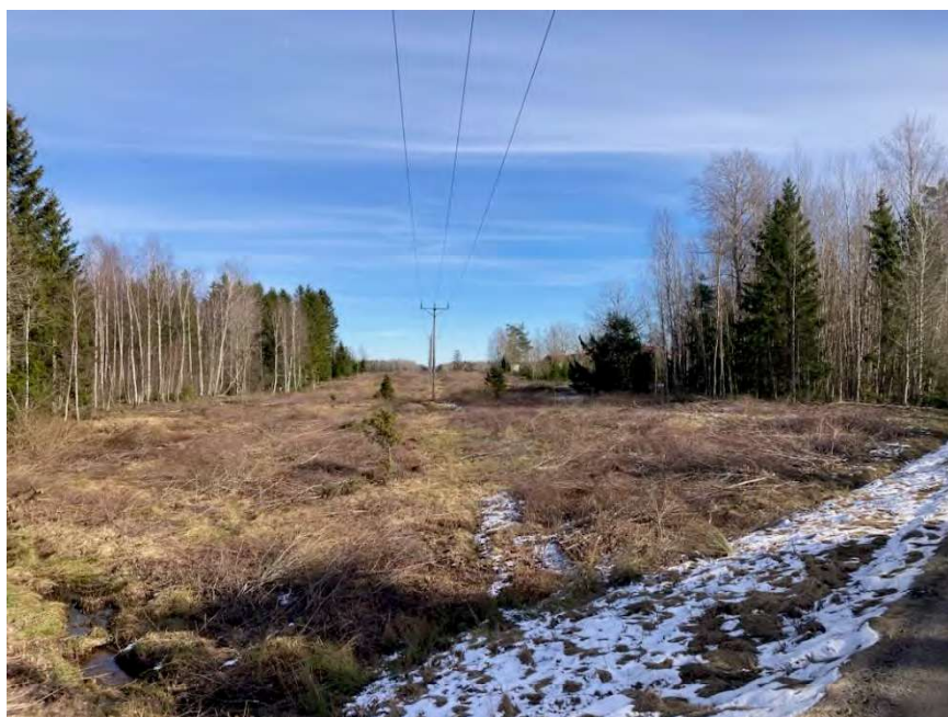
Figur 1 Exempel på 40 kV-ledning (enkelstolpe) i träsäker ledningsgata
